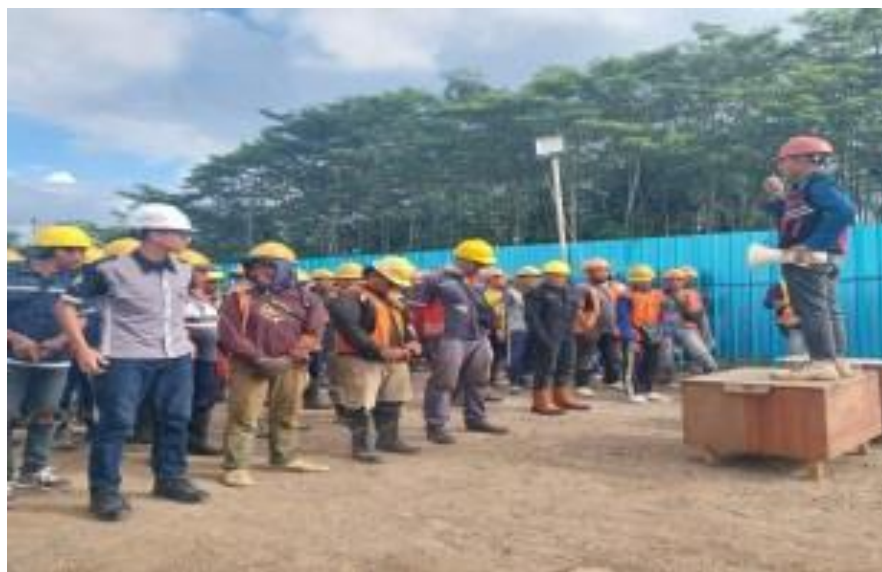
Gambar 4. Kegiatan sosialisasi kepada pekerja konstruksi di Proyek Gedung terpadu Poliwangi
