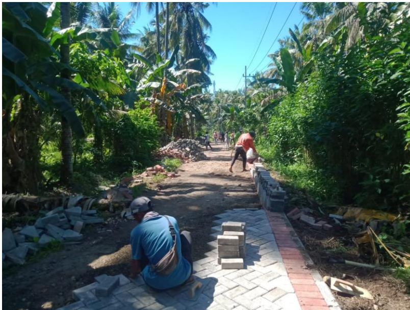
Gambar 2. Kegiatan Pemasangan Paving Blok
