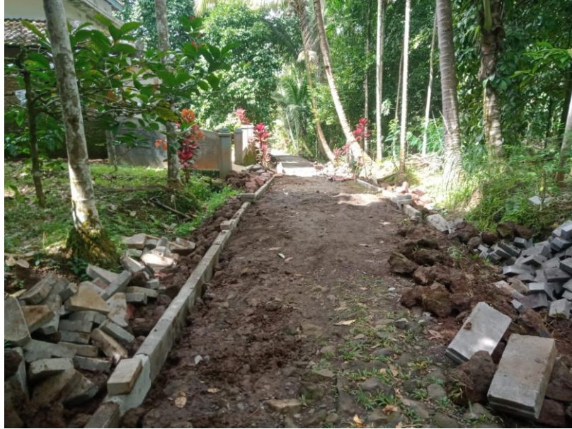
Gambar 1. Kegiatan Pemasangan Kanstin Beton
