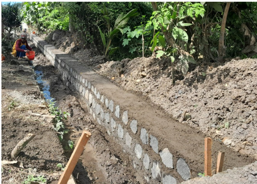
Gambar 2 Pemasangan Dinding Plengsekan
