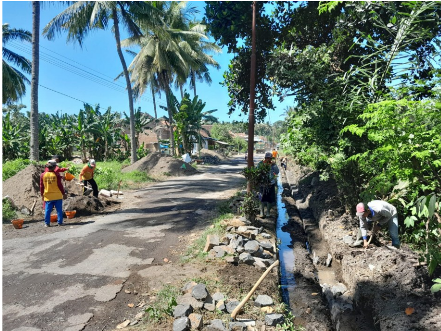
Gambar 1 Pemasangan Pondasi Plengsekan
