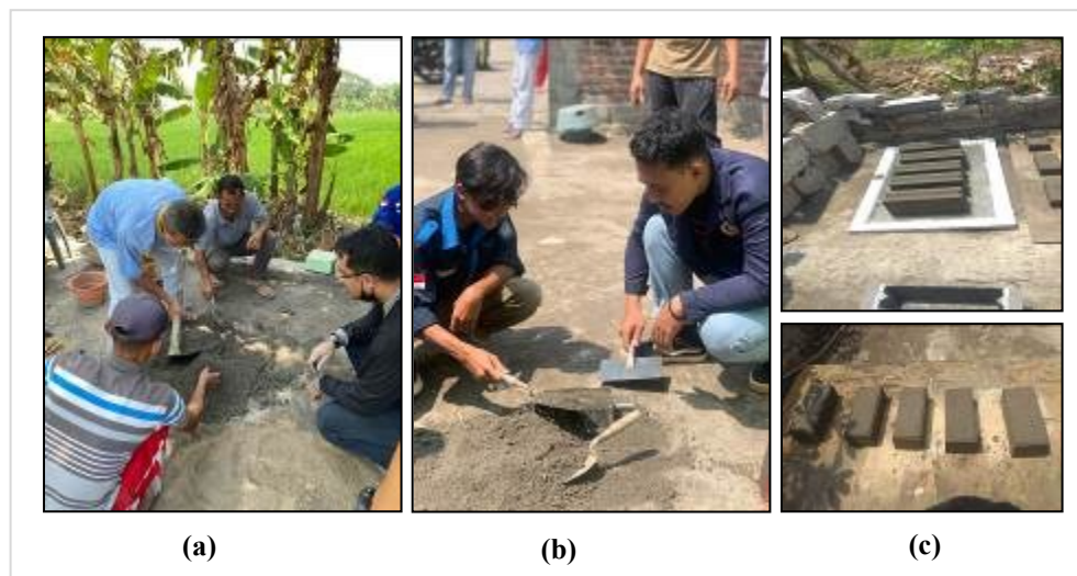
Gambar 8. Pelatihan proses pembuatan paving dan batako: (a) Pengadukan campuran. (b) Pencetakan. (c) Penjemuran hasil cetakan Paving dan Batako.
