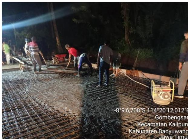
Gambar 2. Kegiatan pengecoran plat
